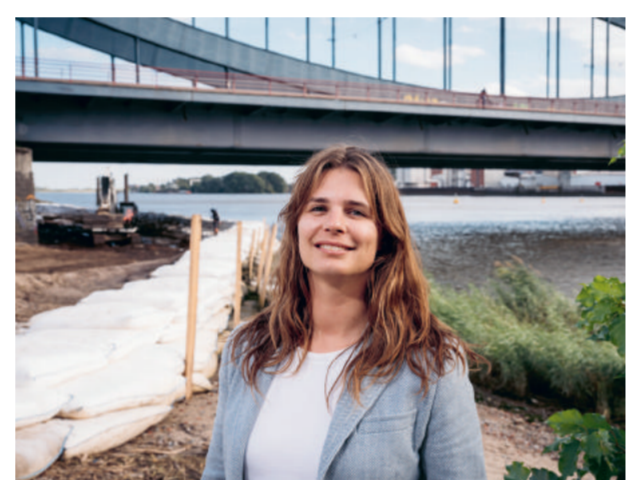
↑ Auf der Baustelle von Carolin Sieger hat bereits der Bau der Zuwegung für die Brücke Entenwerder begonnen © Miguel Ferraz Araujo
